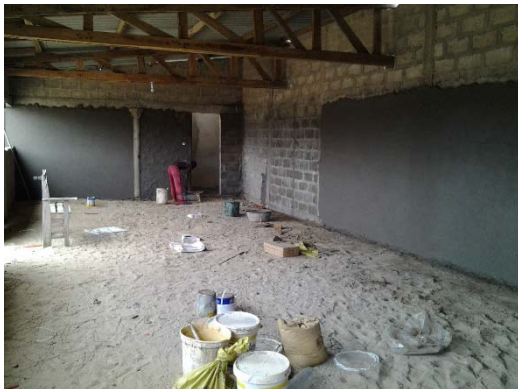
Die Kantine wird gebaut
