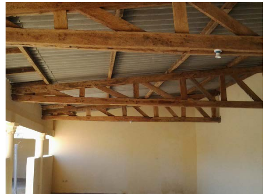
Starke Träger für spätere Solarpanel
